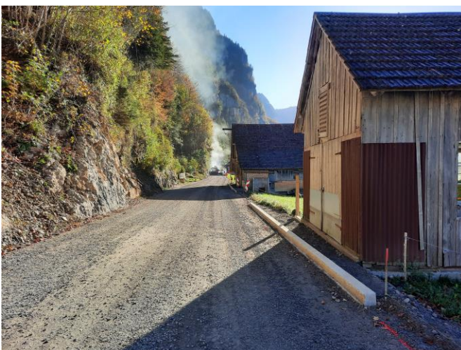
TS1 am 29.10.2024: Planie beim Brennhüttli vor dem Belagseinbau.
