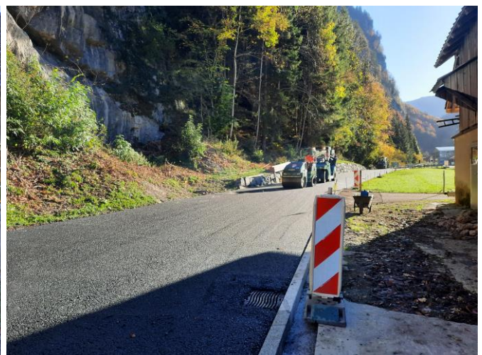
TS1 am 29.10.2024 Belagseinbau Balm.
