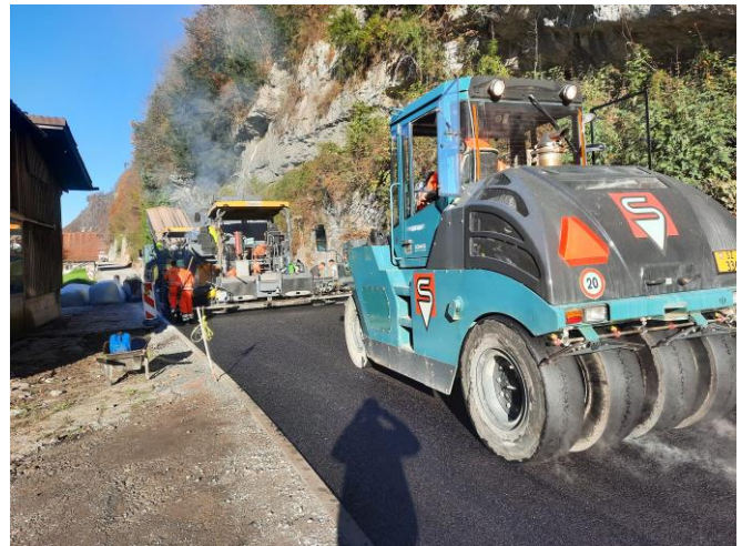
TS1 am 29.10.2024: Belagsarbeiten Tragschicht mit mehreren 100 Tonnen bituminöser Asphaltbelag.
