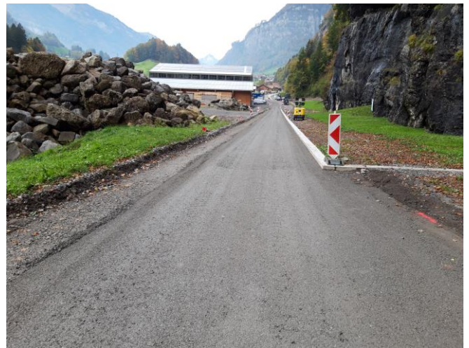
TS 2 am 16.10.2024: Planie vorbereitet am Tag vor dem grossen Belagseinbau.
