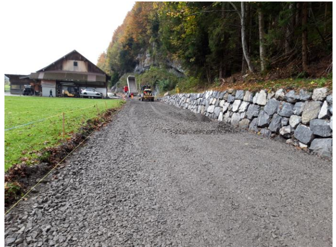
TS1 am 23.10.2024: Planie resp. Vorbereitungsarbeiten für Belagseinbau Tragschicht im Balm in Richtung Stützli.
