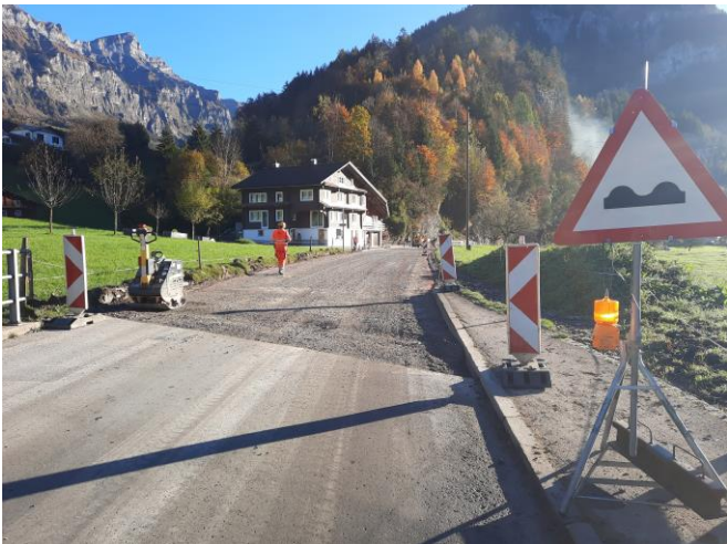
TS1 am 29.10.2024: Belagsarbeiten Tragschicht zwischen Balm, schlichenden Brünnen Brücke bis Stützli, Starzlenbachbrücke
