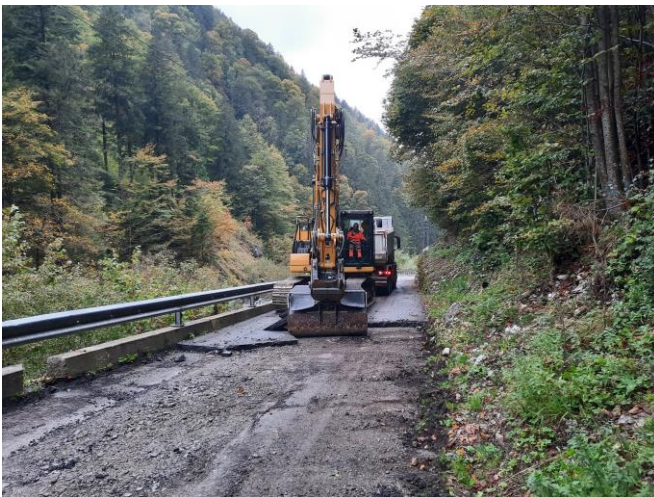
TS 2 am 08.10.2024: Parallel zum Einbau Deckbelag wird der bestehende Belag beim Herrgottstutz abgebrochen.
