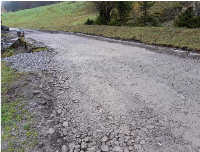
TS2 am 23.10.2024: Foundation im Abschnitt Seeberg / Brünnen erstellen. Belagseinbau Tragsicht Ende Oktober 2024.
