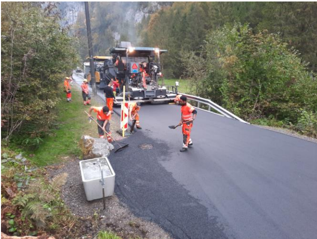
TS 2 am 08.10.2024: Belagsarbeiten Deckbelag zwischen Steinweid und Zwingsbrücke.
