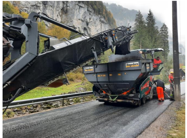
TS 2 am 08.10.2024: Im Bild Einbau bei der Euschplanggen mit Fertiger.
