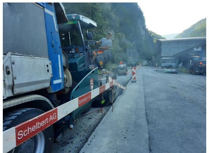
TS1: Einbau Belag Tragschicht nördl. Fahrbahn von Brücke schlichende Brünnen bis Gewerbe
