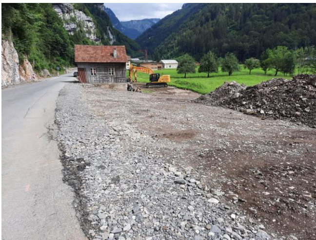
TS1: Fertigstellungsarbeiten Gelände im Balm / Brennhüttli (Juli)
