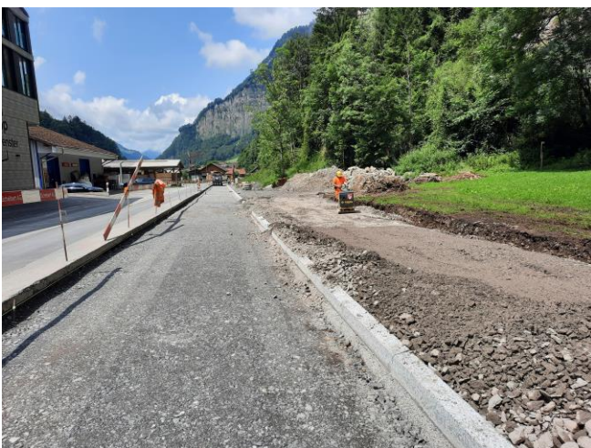
TS1: Einbau Fundation nördl. Fahrbahn von Brücke schlichende Brünnen bis Gewerbe
