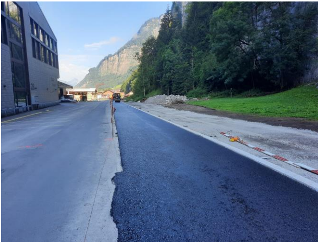
TS1: Belagsarbeiten nördliche Fahrbahn entlang Gewerbe (Ende Juli)
