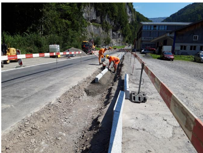
TS1: Randsteine setzen entlang Gewerbe
