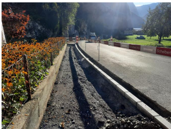
TS1: Randsteine setzen im Balm (Mitte – Ende Sept.)
