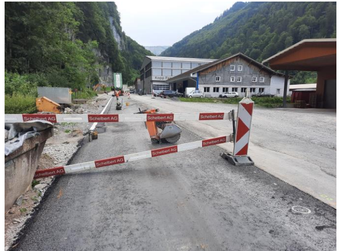
TS1: Anpassungsarbeiten / Strassenbauarbeiten zw. Brücke schlichende Brünnen bis Gewerbe (Juli)
