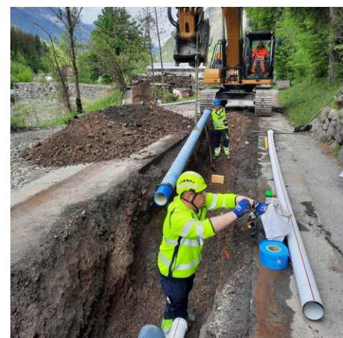
TS2 Steinbruch Höch Murä: Verlegen der Wasserleitung durch die WGM am Mi. 08.05.2024.
