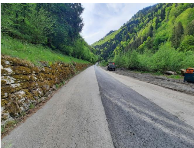
TS2: Prov. Belagseinbau zwischen Herrgottstutz bis vor Höch Murä am Fr. 03.05.2024
