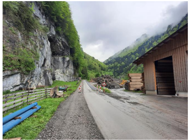
TS2: Prov. Belagseinbau zwischen Höch Murä bis Balm (Kopp Fenster) am Mi. 08.05.2024
