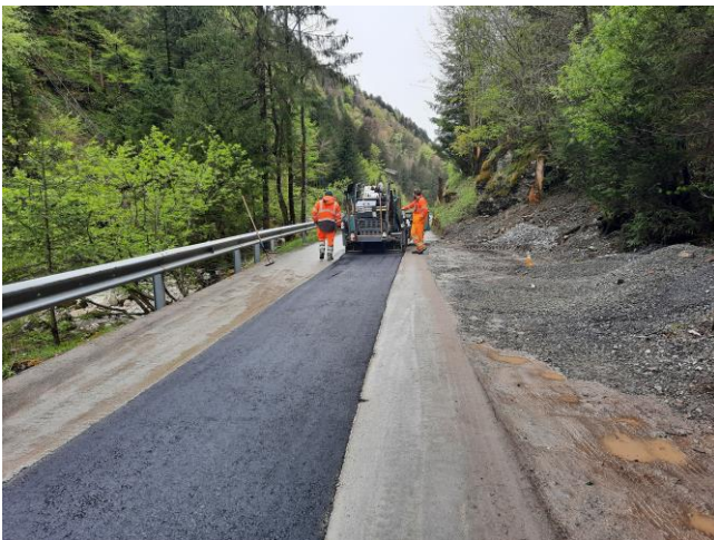
TS2: Prov. Belagseinbau zwischen Cholplatz und bis unter Herrgottstutz am Fr. 19.04.2024
