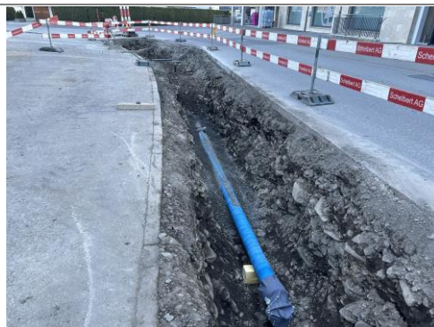
04.04.2025 / Marktstrasse – Anschluss Trinkwasserleitung
