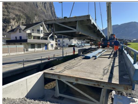
04.04.2025 / Weid – Einbau Hilfsbrücke Bürgelibach
