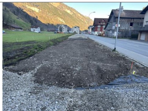
04.04.2025 / Adelmatt – prov. Trasse / Aushub und Koffering
