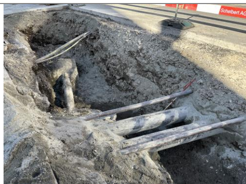
02.04.2025 / Marktstrasse – Sondage Trinkwasserleitung
